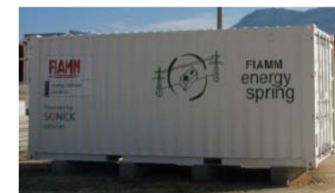
Batterie Na/NiCl 2 Fiamm 140kWh/120kW
